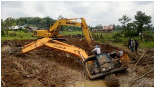
Gambar 67. Excavator terjebak di lumpur
