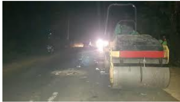
Gambar 51. Tandem roller kurang pencahayaan
