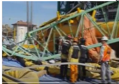
Gambar 65. Crane jatuh dan menewaskan pekerja
