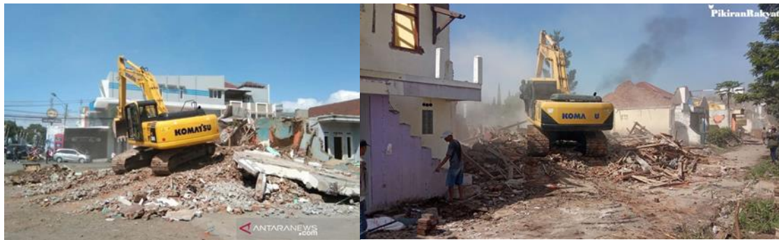
Gambar 66. lokasi excavator clamshell
