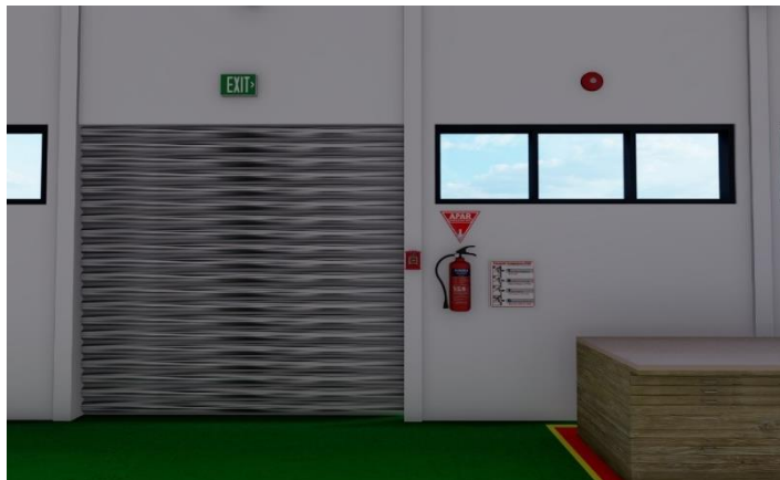
Gambar 6. 34 Ilustrasi Pemasangan APAR
